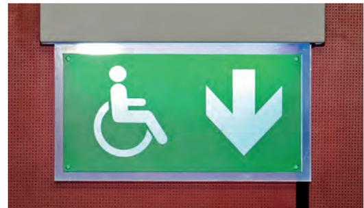
Abb. 32: Kennzeichnung eines Fluchtweges für Rollstuhlbenutzer
