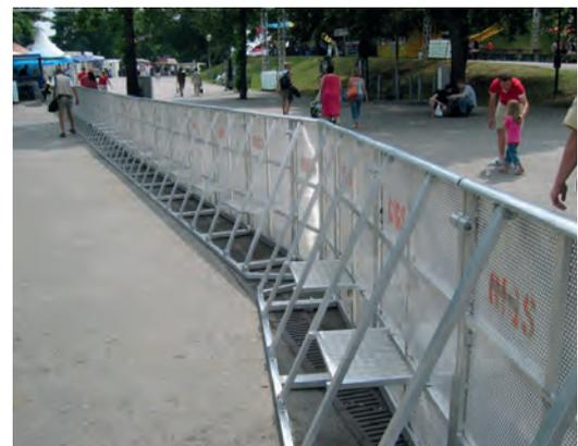
Abb. 14: Absperrung innerhalb eines Stehplatzbereiches – Rückansicht
